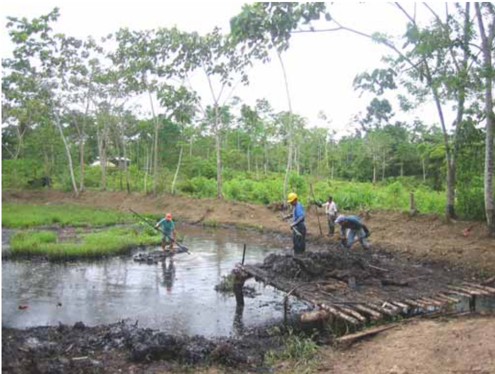
Arbeiter ohne Schutzkleidung reinigen eine von über 600 offenen Gruben, in denen seit über 30 Jahren schwermetallhaltige Abwässer aus der Erdölförderung versickern
